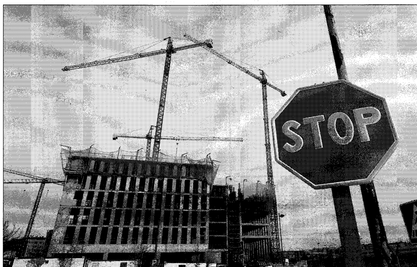
Un bloque de pisos en construcción, una de las actividades que mantendrá el visado obligatorio.
