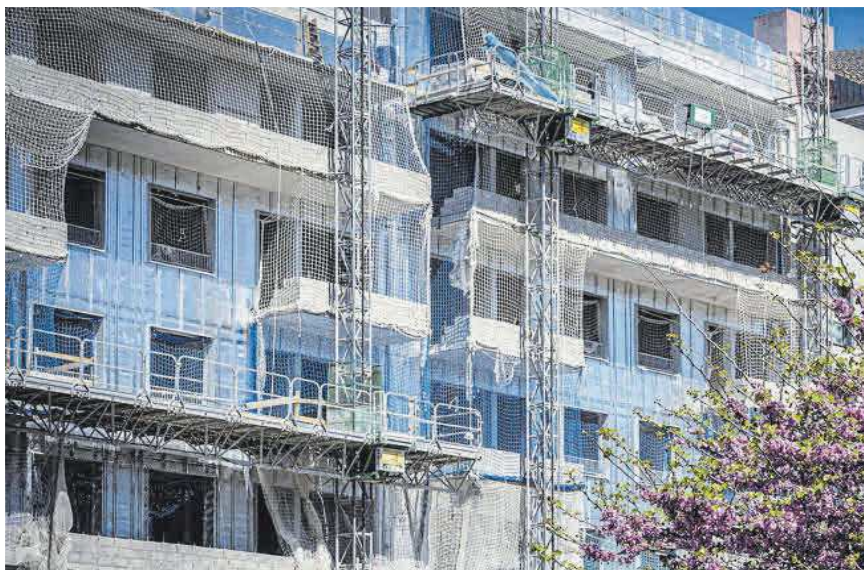
Construcción de edificios en la Vila Olímpica de BCN.
