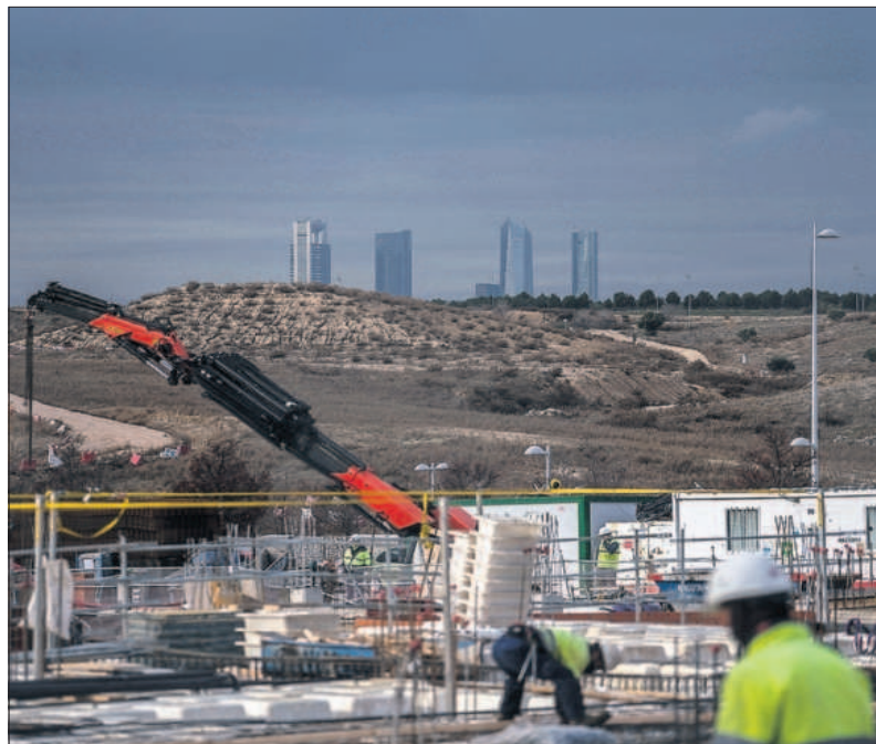
Varios empleados, en las obras de construcción de edificios residenciales en Valdebebas (Madrid). / OLMO CALVO
