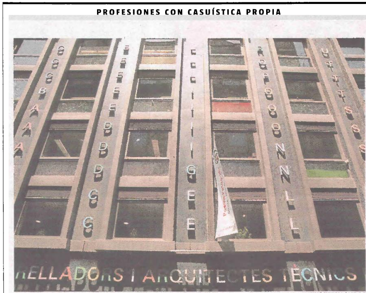
Sede del Col·legi d'Aparelladors i d'Arquitectes Tècnics de Catalunya en Barcelona
