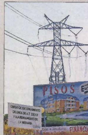
Obras en Red Eléctrica. / J. AYMA
