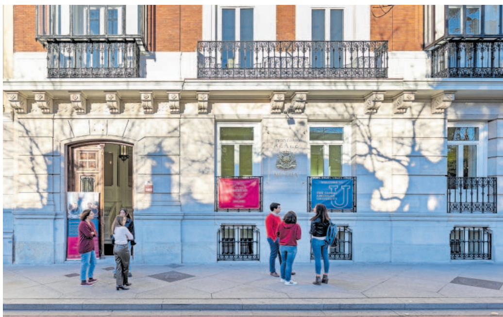
Nueva sede de Schiller International University en el centro de Madrid.
